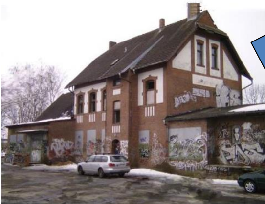
A wie abrisssreif
