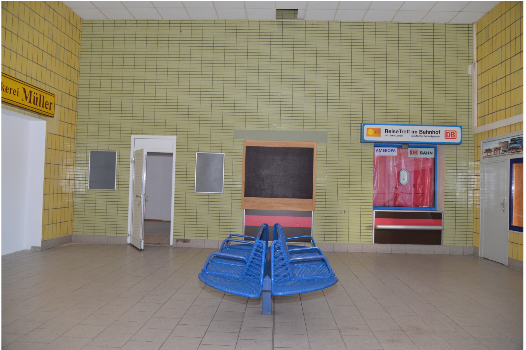
Bahnhofsgebäude vor der Sanierung – innen
