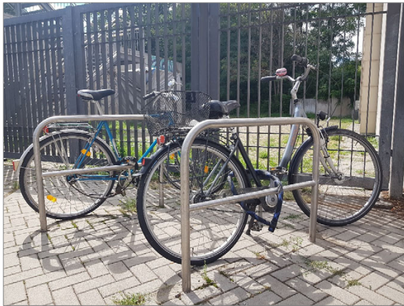
Anlehnbügel mit Knieholm (am Knieholm kann der Fahrradrahmen angeschlossen werden)
