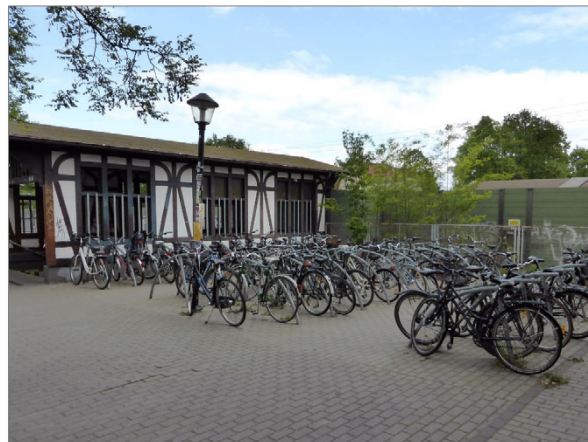
B+R: nicht optimale Stellplätze aufgrund fehlender Überdachung am Bahnhof Dallgow-Döberitz
