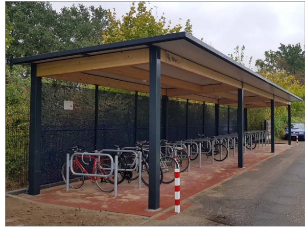
Anlehnbügel mit Knieholm (in einer modularen, vielfach gebauten Anlage in Schleswig-Holstein)
